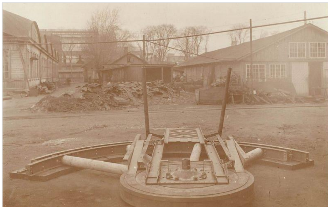
Платформа системы В.Г. Шухова под 6-дюймовые пушки
